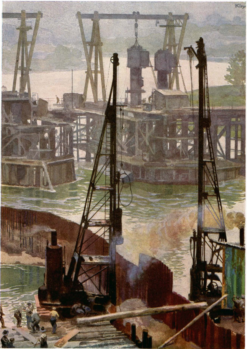
WEHRBAU JETTENBACH AM INN
